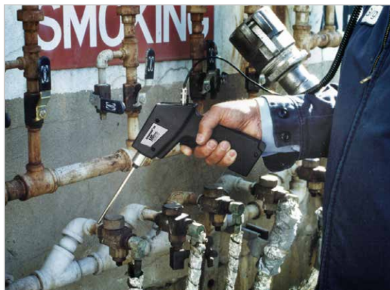
kontrola odváděčů kondenzátu
