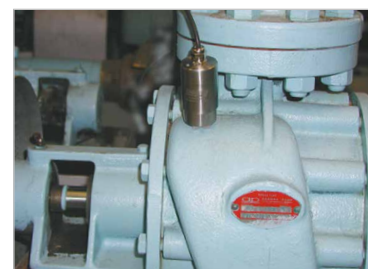
Sleduje kavitaci, ložiska a ventily
